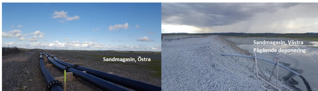
Figur 2. Distributionsledning för anrikningssand samt sandmagasinets östra och västra delar, fotograferade i augusti 2018 (Golder, 2018).
