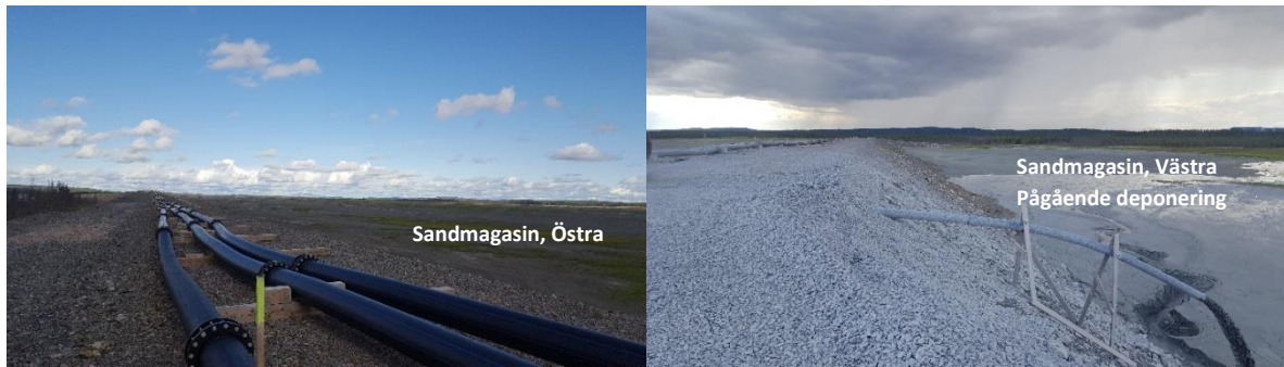
Figur 30: Foton som visar distributionsledningar för anrikningssand samt sandmagasinets östra och västra sidor (Golder, 2018).
