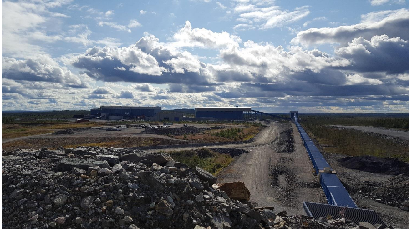
Figur 24: Foto i sydlig riktning som visar transportbandet för krossad malm från Tapuli dagbrott med malmlagringsbyggnader och anrikningsverk i bakgrunden (Golder, 2018).
