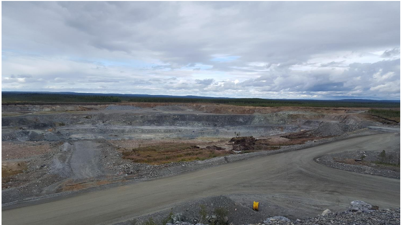
Figur 22: Foto i nordnordvästlig riktning som visar pågående brytning i Tapuli dagbrott (Golder, 2018).
