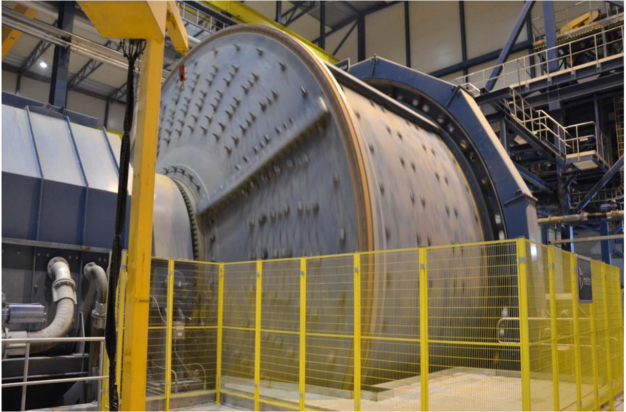
Figur 25: Bild som visar anrikningsverkets primärkvarn.
