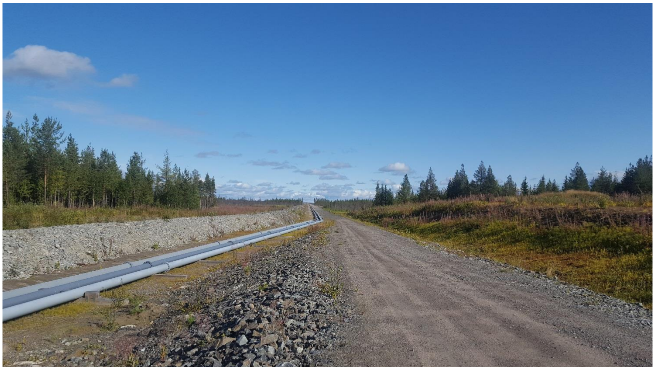
Figur 10: Foto från väg 99 i östlig riktning som visar pumpledningar för anrikningssand, transportväg till sand- och klarningsmagasin (Golder, 2018).
