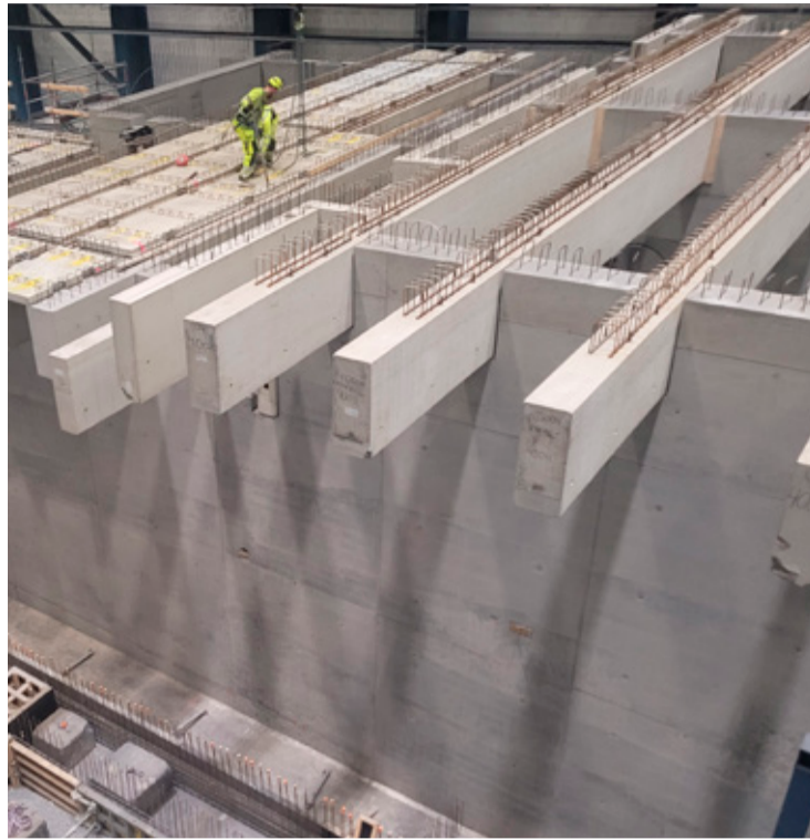
Montering av prefab till fundament.
