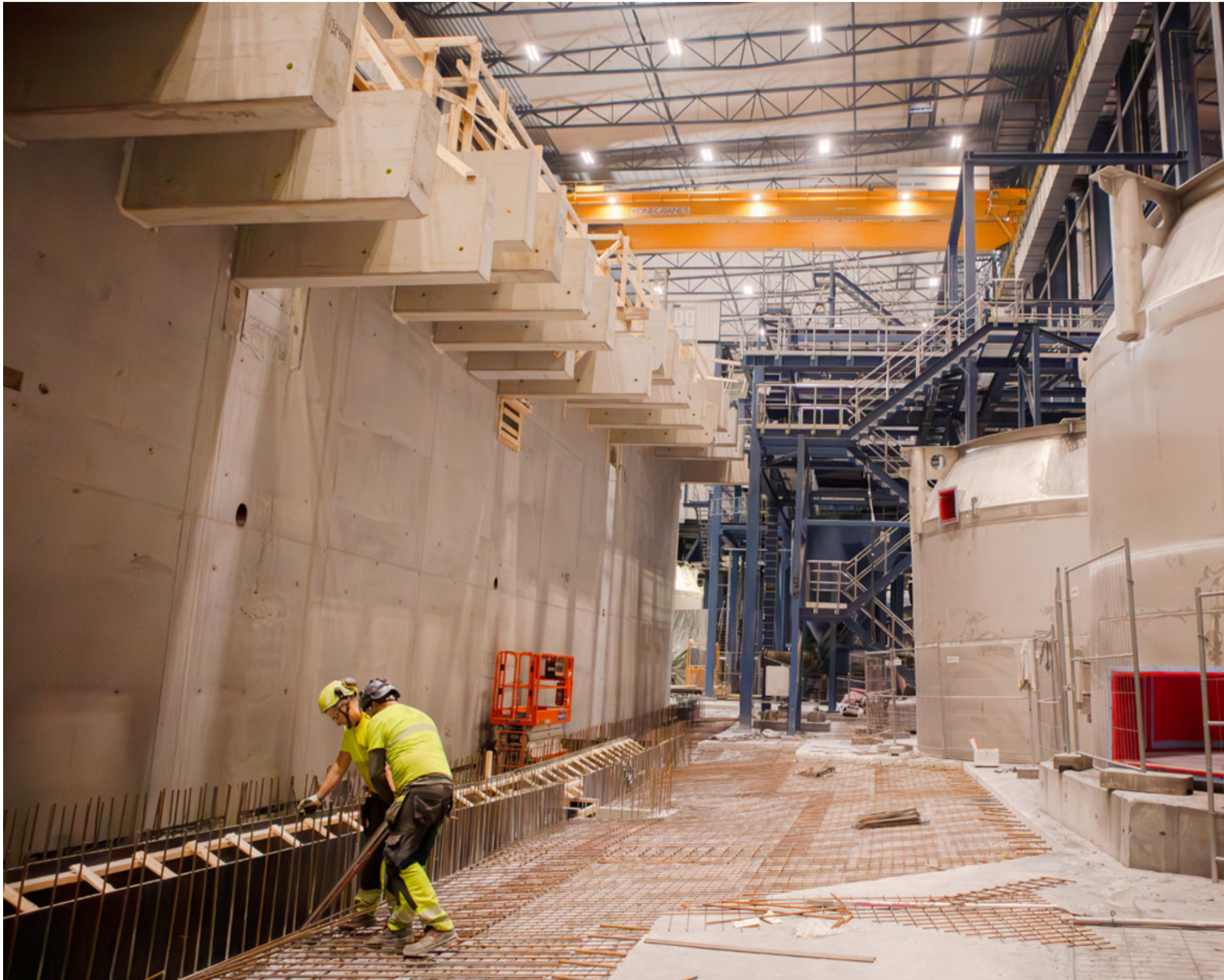
Arbete vid fundamenten till flotationsstankarna.
