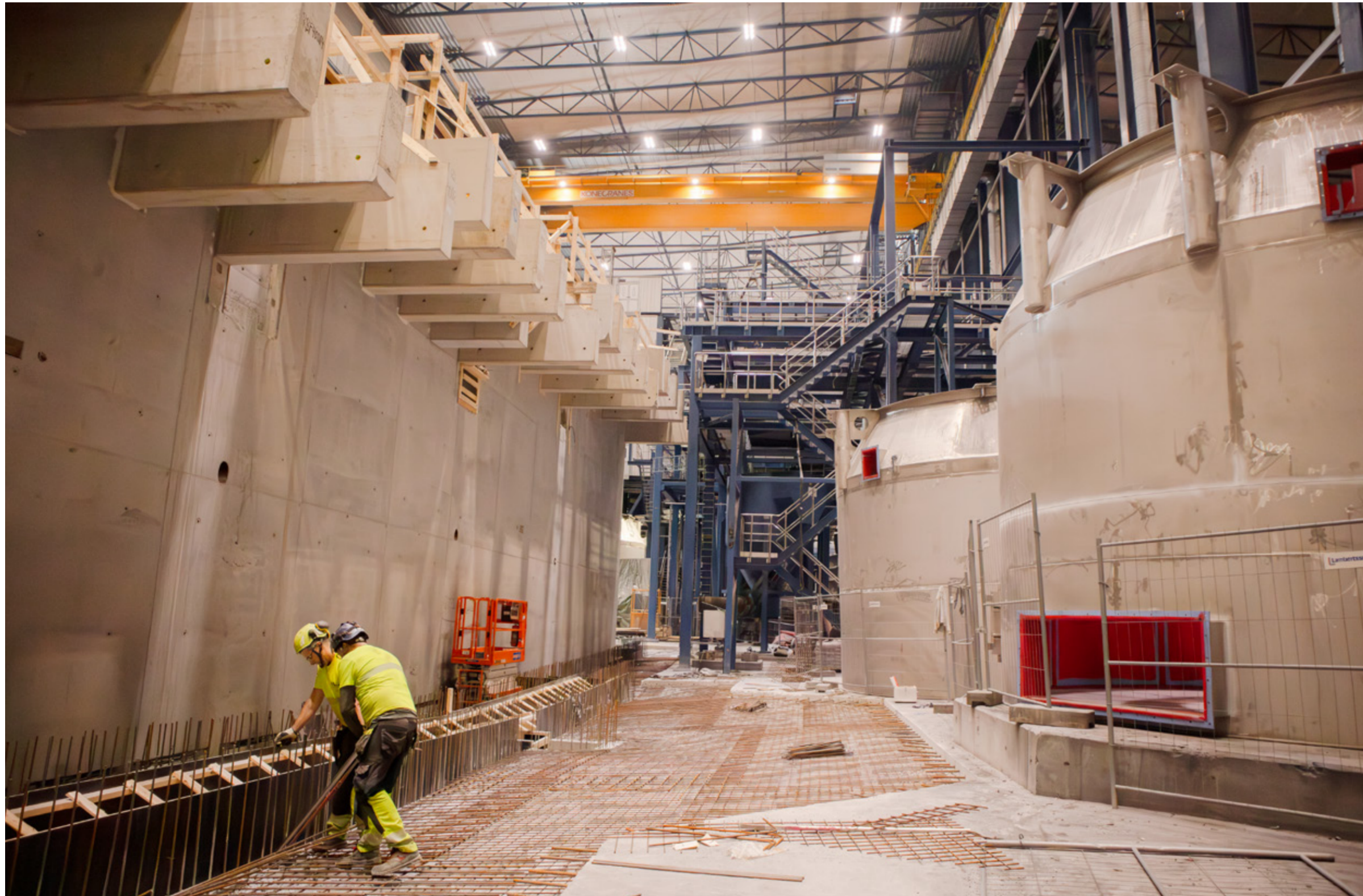
Arbete vid fundamenten till flotationsstankarna.
